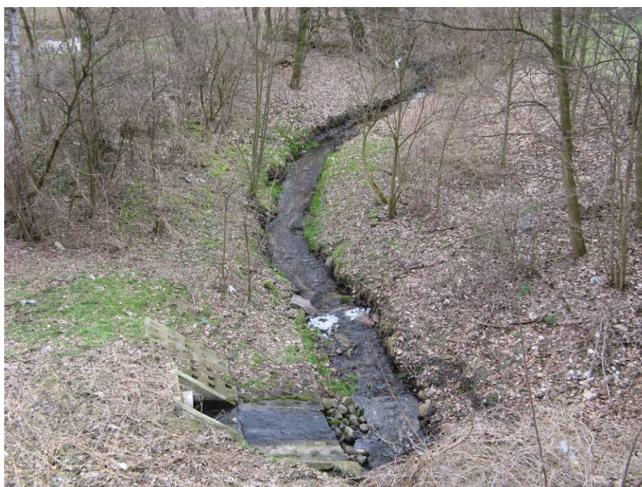
Fot.10. Rów Jezierski z wylotem kanalizacji deszczowej w Zaniemyślu
