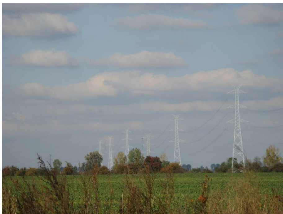
Fot.13. Linia wysokiego napięcia, okolice Pigłowic
