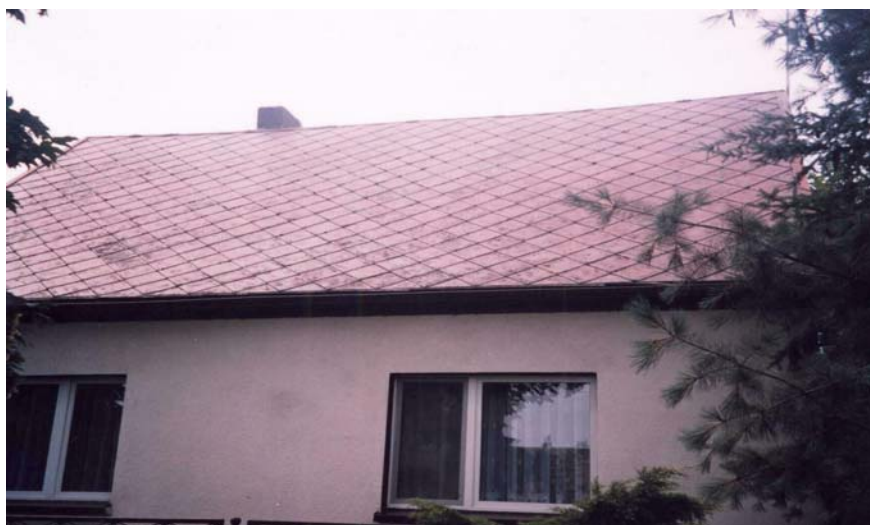
Fot.3. Płyty typu KARO na budynku jednorodzinnym w Sulęcinie gm. Krzykosy.
