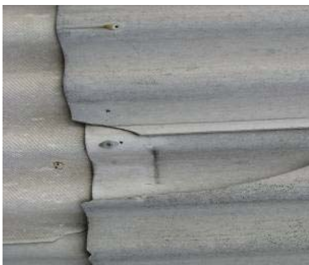
Fot. 9. Odlamane narożniki płyty eternitowej – zdjęcie mikro i makroskopowe.
