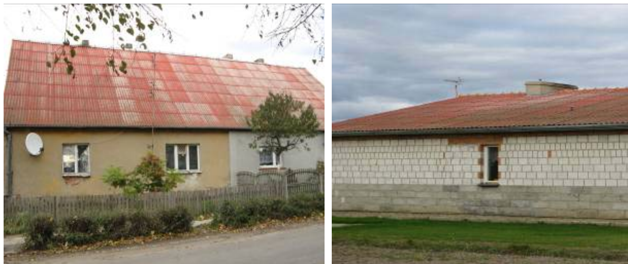
Fot. 7. Płyty eternitowe pomalowane farbą na budynkach mieszkalnych w Jaszkuwie i Śnieciskach.
