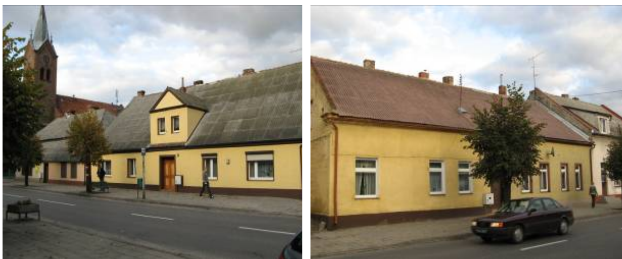
Fot. 5. Płyty azbestowo-cementowe faliste na budynkach wielorodzinnych przy ul. Poznańskiej w Zaniemyślu
