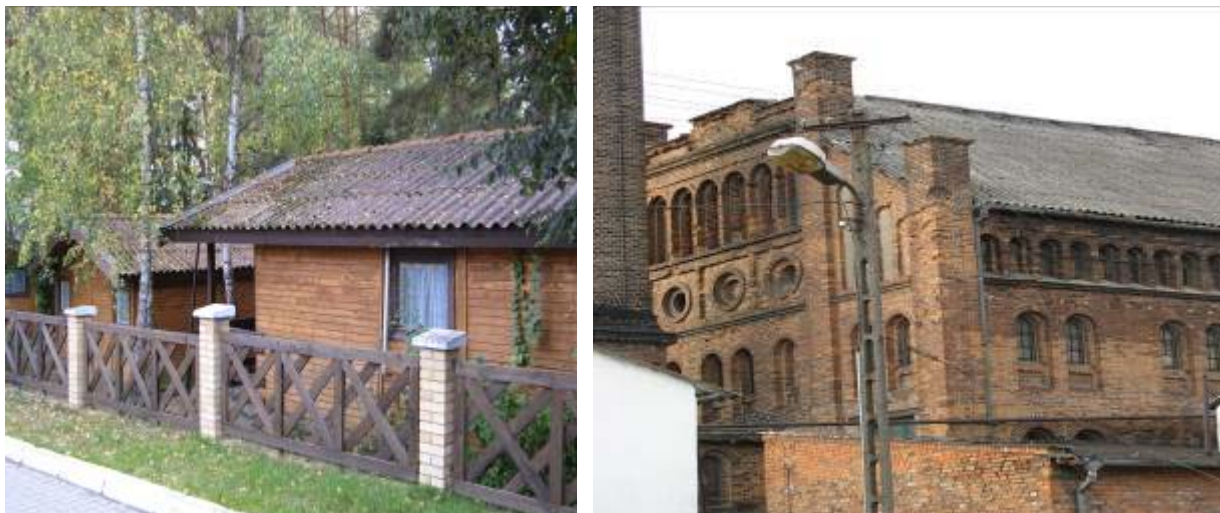
Fot. 4. Płyty azbestowo-cementowe faliste na domkach kempingowych ośrodka Niezamyśl i gorzelni w Śnieciskach.
