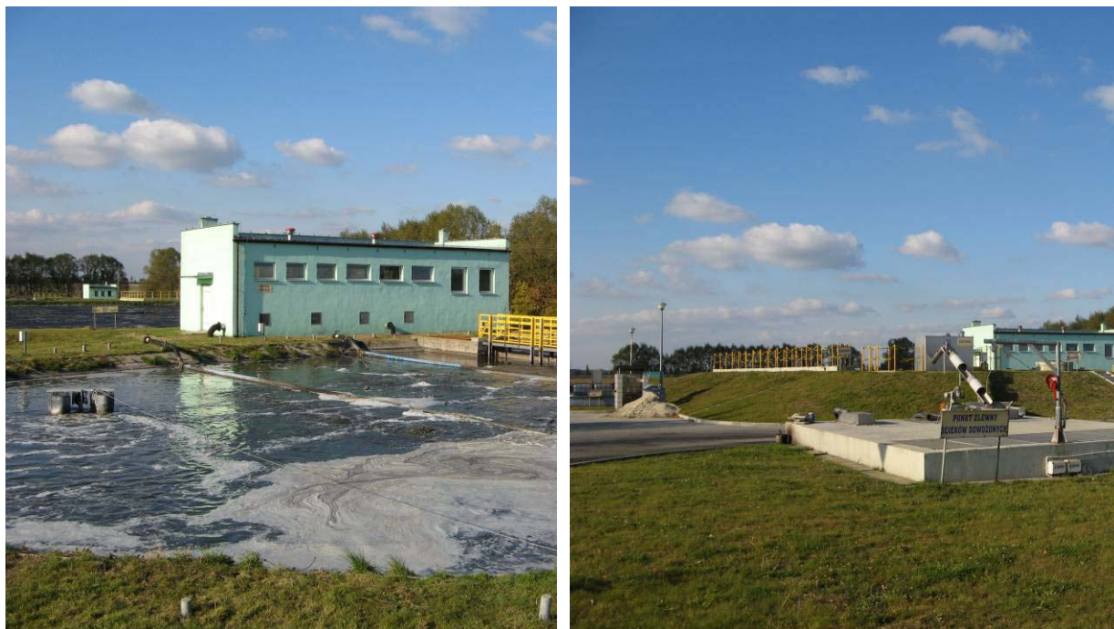
Fot.11 i 12. Gminna oczyszczalnia ścieków w Łękanie
