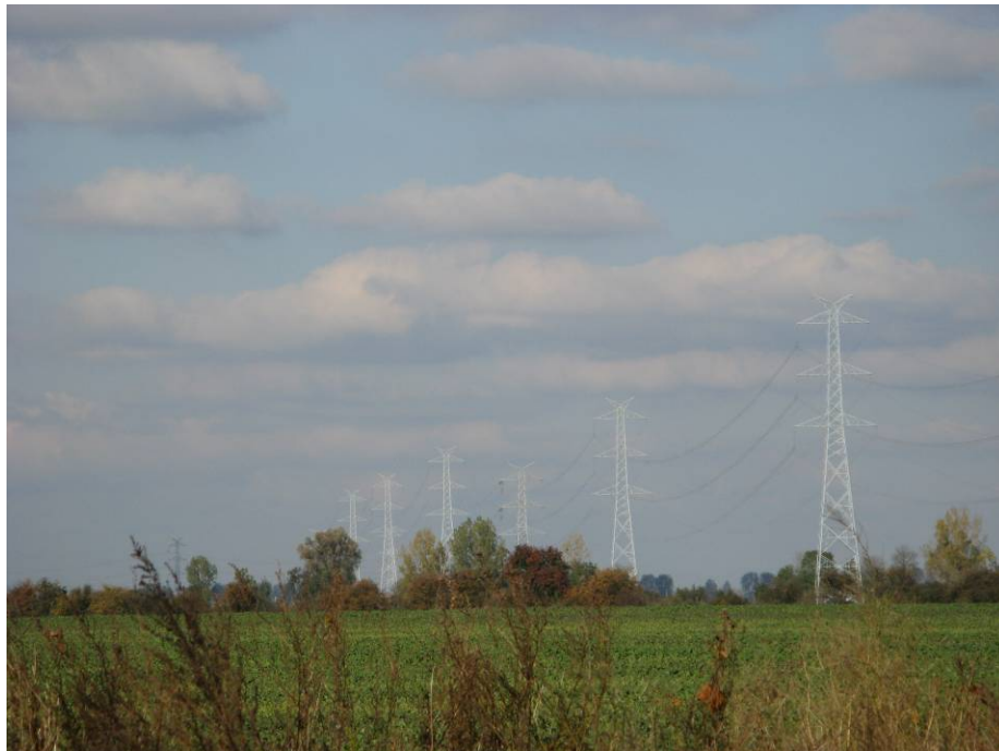
Fot.13. Linia wysokiego napięcia, okolice Pigłowic
