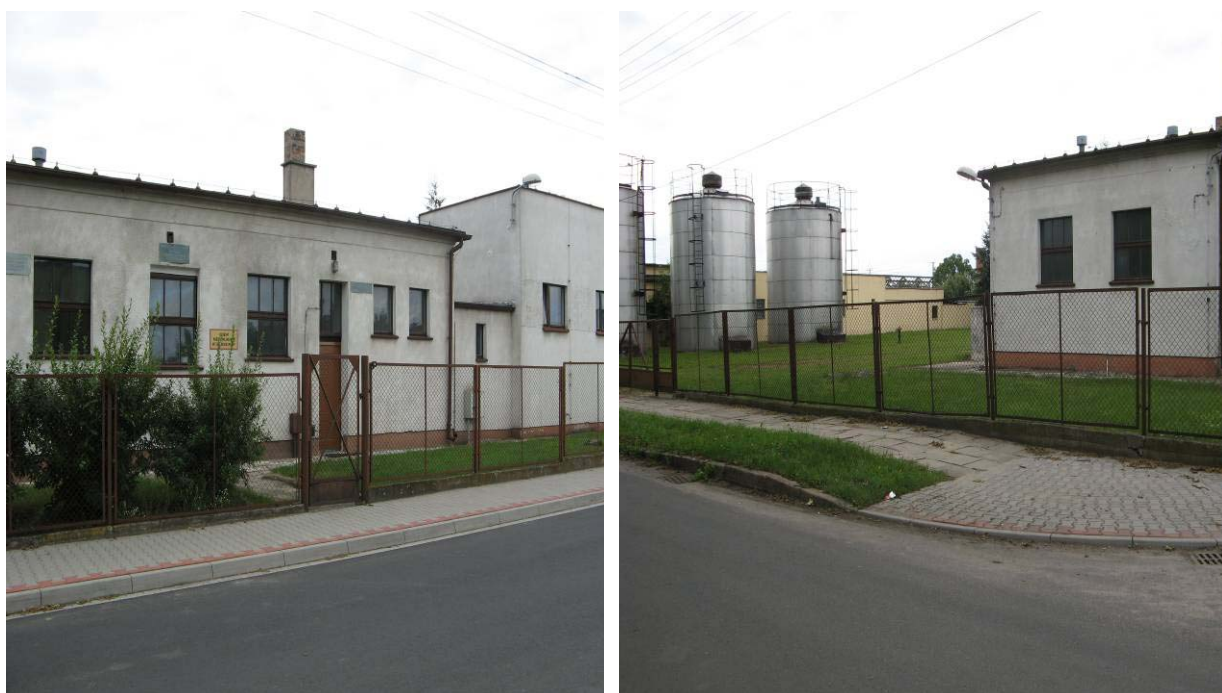
Fot.13 i 14. Stacja uzdatniania wody w Zaniemyślu
